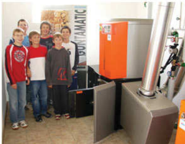
Zařízení na vytápění peletami pro podnikatelské objekty, školy nebo obytné domy
